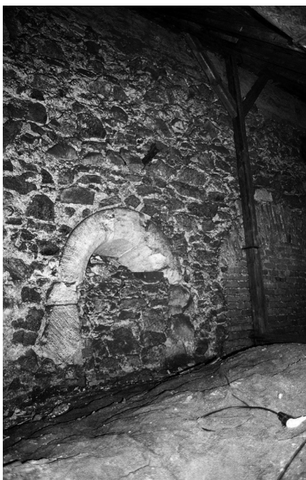
Abb. 3: Kirche Hirschfelde, Rest einer romanischen Fensteröffnung an der Chorsüdwand; sichtbar im Dachraum der Südhalle, 2003 (Foto: W. Menzel)
