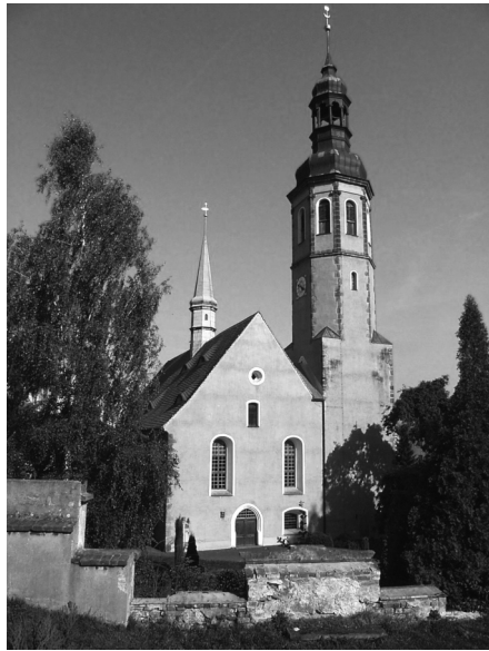
Abb. 1: Kirche Hirschfelde, Außenansicht von West, (Foto: W. Menzel)
