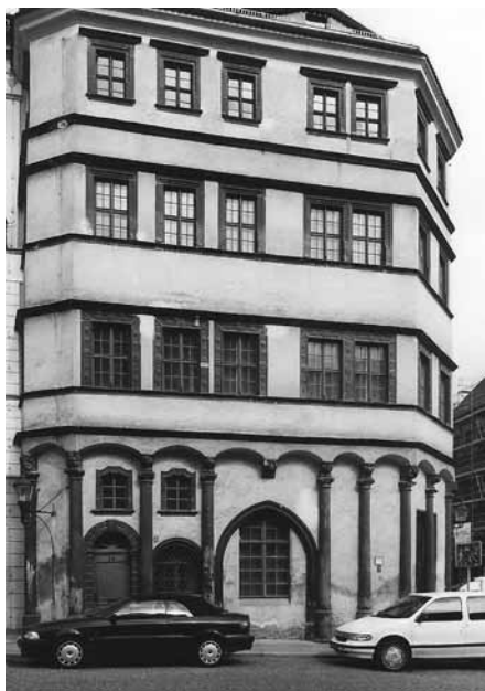
Abb. 5. Görlitz, Alte Waage , Fassadenumgestaltung 1600–1606.
