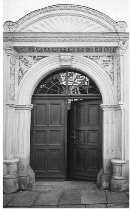
Abb. 7. Görlitz, Peterstraße 8, Portal, 1528.
