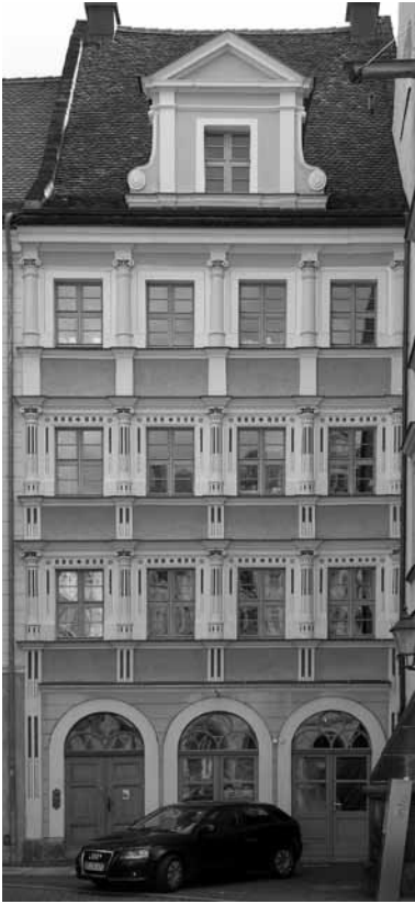
Abb. 3. Görlitz, Peterstraße 17, Fassadengestaltung, um 1550
